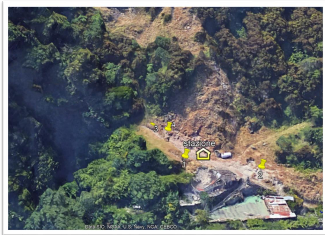
Figura 4.2.2 - Ubicazione in località Pizzone Mt. Cito della stazione e dei punti di misura della temperatura.
