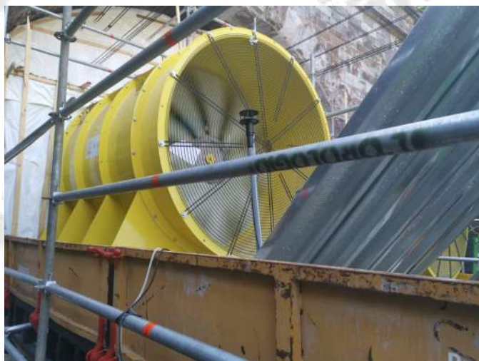
Figura 4.23 - Stazione geochimica per la misura dell'intensità e direzione del vento e della concentrazione di \text{CO}_2 installata all'uscita del flusso di una delle due turbine. Le turbine sono state accese il giorno 8 luglio.
