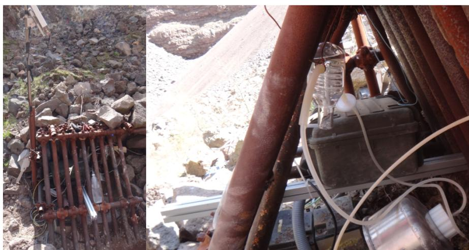
**Figura 4.4** - Installazione della nuova stazione geochimica in area di fondo cratere. La particolare struttura è necessaria per difendere la stazione da possibili eventi franosi.
