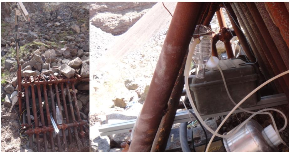
**Figura 4.6** - Installazione della nuova stazione geochimica in area di fondo cratere. La particolare struttura è necessaria per difendere la stazione da possibili eventi franosi.
